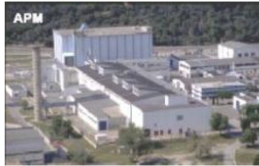
Figure 2.2-1 L'atelier pilote de Marcoule APM (source CEA)
