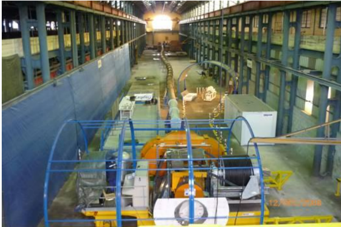
Figure 4.1-5 Test de retrait d'un colis HA dans un alvéole fortement déformé
