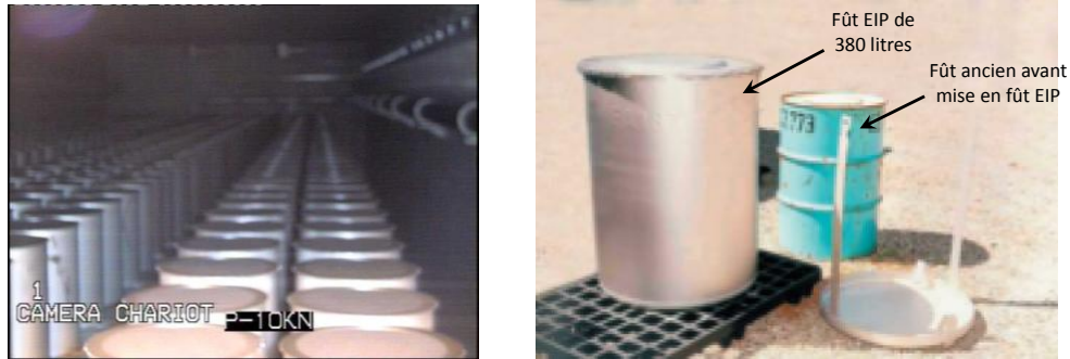
Figure 2.3-1 Vue intérieure de l'entreposage intermédiaire polyvalent EIP et fût EIP en acier inoxydable de 380 litres (source CEA)
