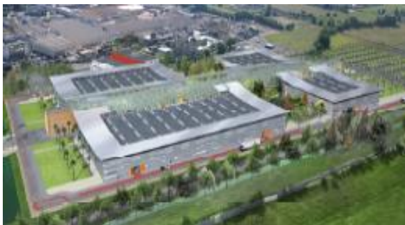
Projet EOLE – Bâtiment technique et de bureaux
