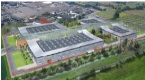
Projet EOLE - Bâtiment technique et de bureaux
