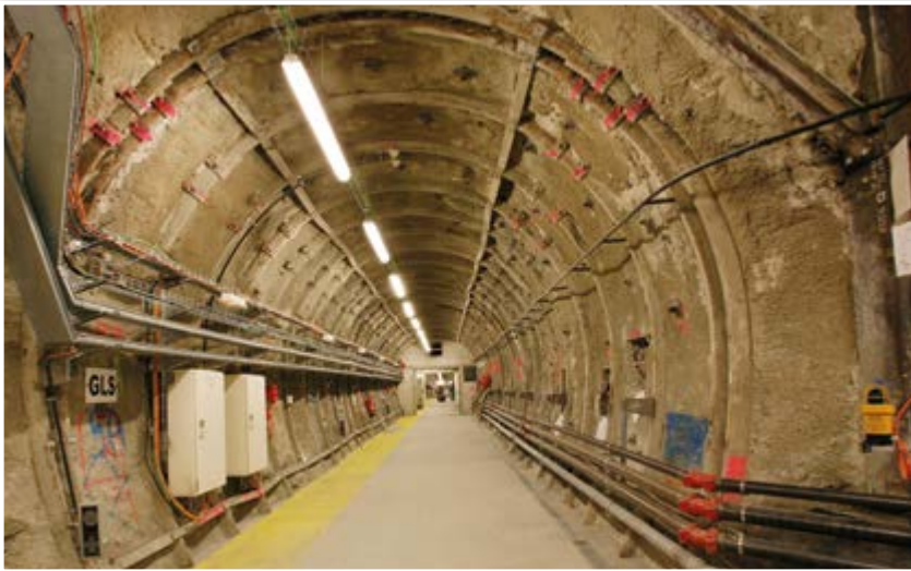
► Galerie du Laboratoire souterrain
