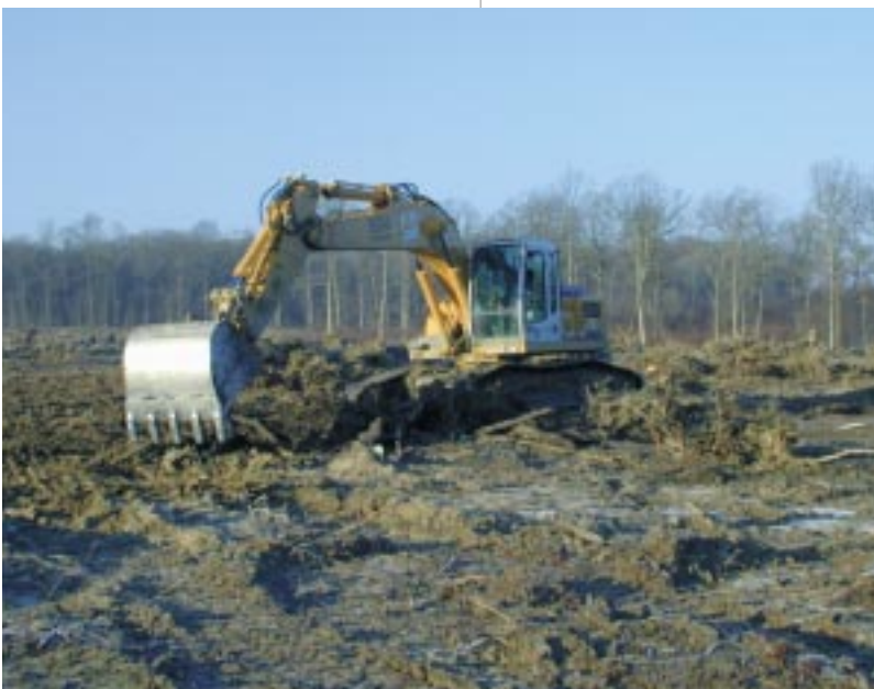
Dessouchage de la surface déboisée du site
