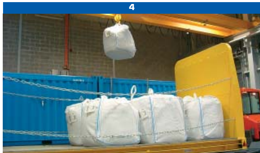
4 • Les colis sont chargés sur la remorque, qui effectuera la navette entre le bâtiment de maintenance et l'alvéole de stockage.
