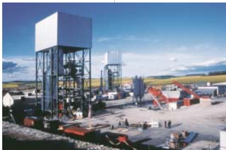
Carreau de fonçage du Laboratoire, vue des deux puits
