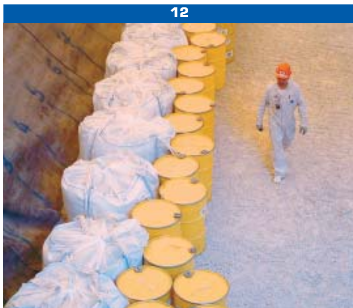
• L'ensemble des colis est recouvert par une couche de sable. Au total, 10 000 m 3 de colis de déchets seront stockés dans l'alvéole, correspondant à six mois d'exploitation environ.
