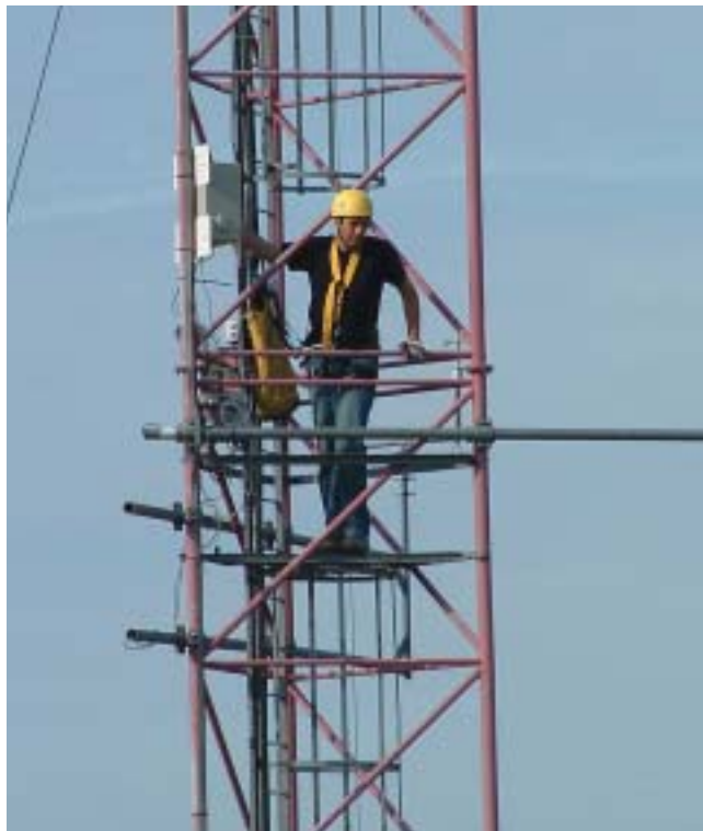
Changement des instruments de mesure de température à 17 mètres...
