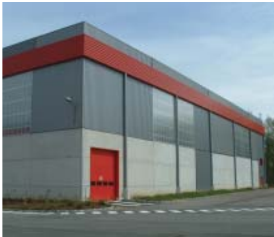
Bâtiment de traitement
