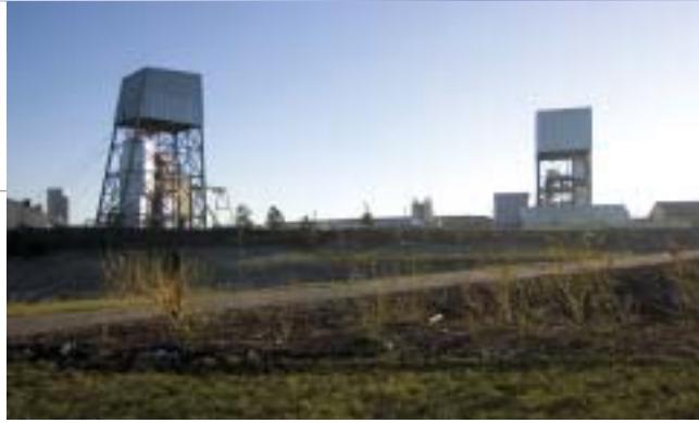
Les chevalements surmontent les deux puits du laboratoire.
