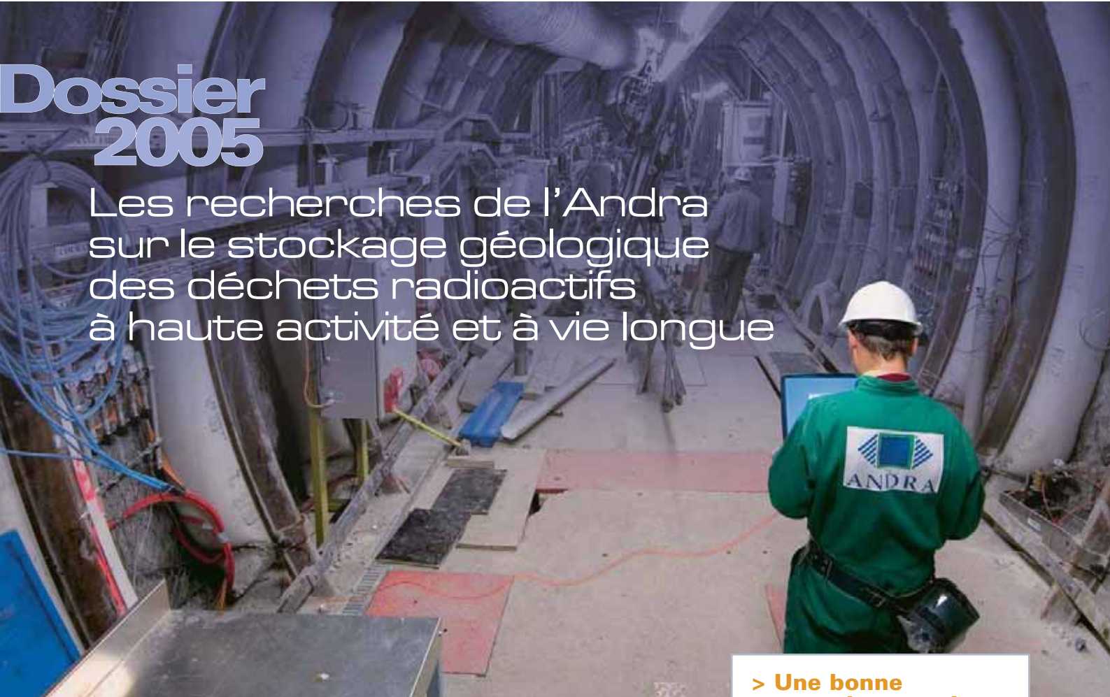
Galerie d'expérimentations (-445 m) du laboratoire souterrain de Meuse / Haute-Marne.
