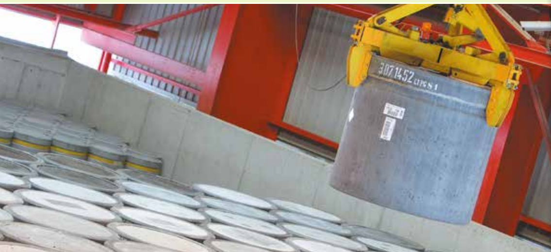
Ouvrage de stockage au CSA
