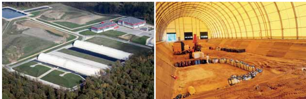
Centre de stockage de déchets de très faible activité (CSTFA)
