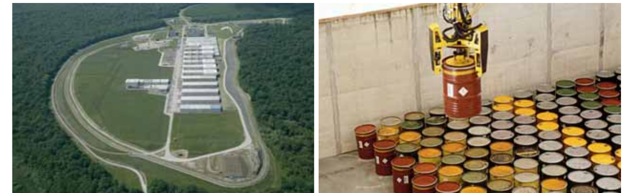
Centre de stockage de déchets de faible et moyenne activité à vie courte (CSFMA)
