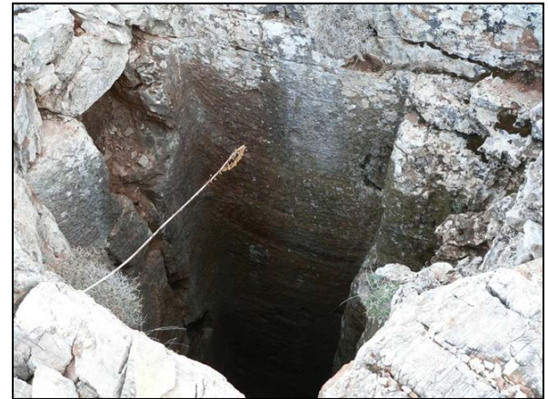
Exemple d'un puits : abandonné en l'état ( mines atteignant plus de 200 m de profondeur)
