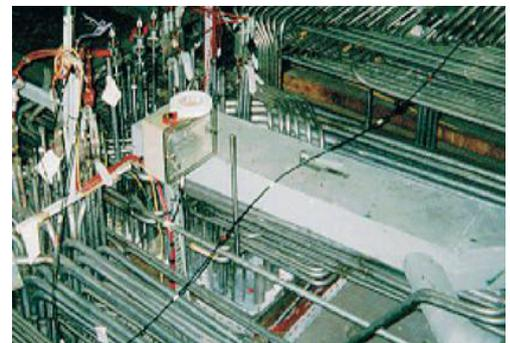
► Figure 1 : Inspection d'un système de tuyauterie contaminé à l'aide d'un système OSL
