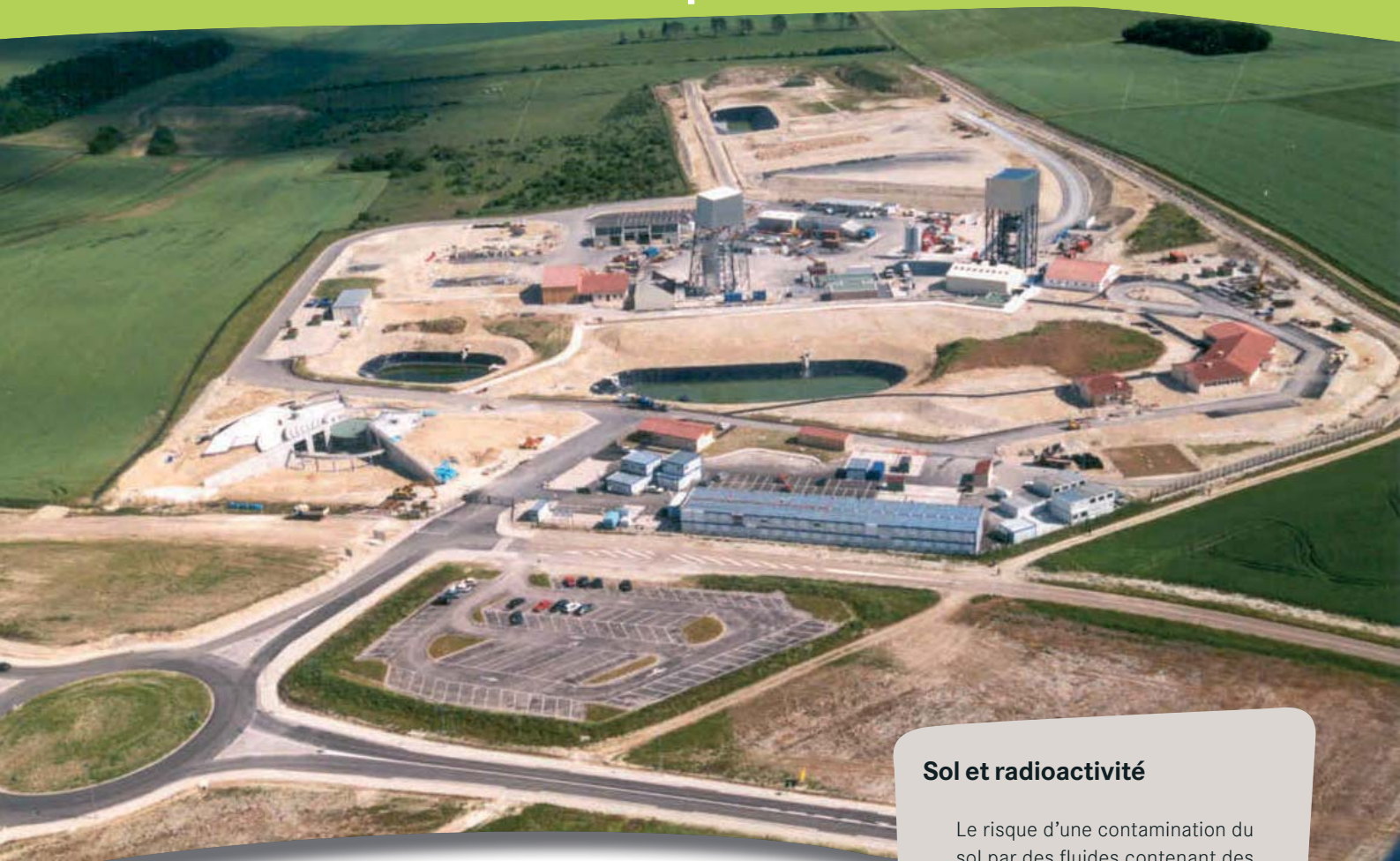
Vue aérienne du site en construction en 2001
