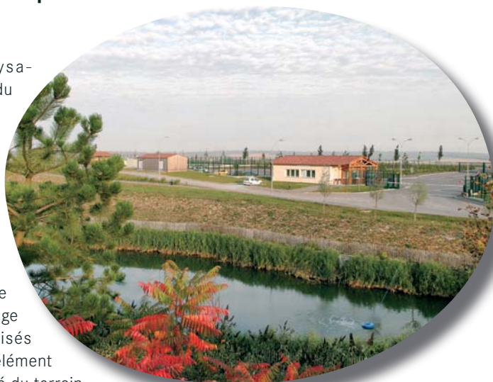
L'un des bassins d'orage du Laboratoire
