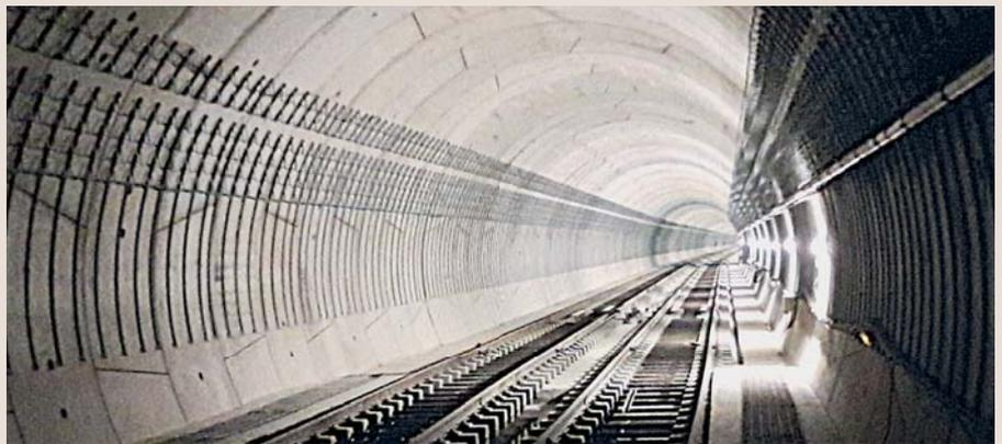
(entre les stations Front Populaire et Mairie d'Aubervilliers), la RATP a mis en place une zone expérimentale dans un tunnel qui n'est pas encore exploité. La RATP a choisi ce site afin de suivre les éventuelles déformations du tunnel lors du terrassement d'un puits de secours à proximité immédiate du tunnel ainsi que du percement de la galerie d'accès reliant ce puits au tunnel.
