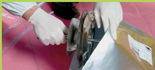
La dépose de paratonnerres radioactifs doit être réalisée par une société spécialisée, habituée et habilitée à les manipuler. Elle se charge de leur dépose, conditionnement, transport et entreposage (dans l'attente de leur enlèvement par l'Andra).
