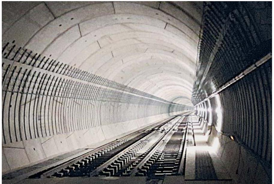
en place une zone expérimentale dans un tunnel qui n'est pas encore exploité. La RATP a choisi ce site afin de suivre les éventuelles déformations du tunnel lors du terrassement d'un puits de secours à proximité immédiate du tunnel ainsi que du percement de la galerie d'accès reliant ce puits au tunnel.
