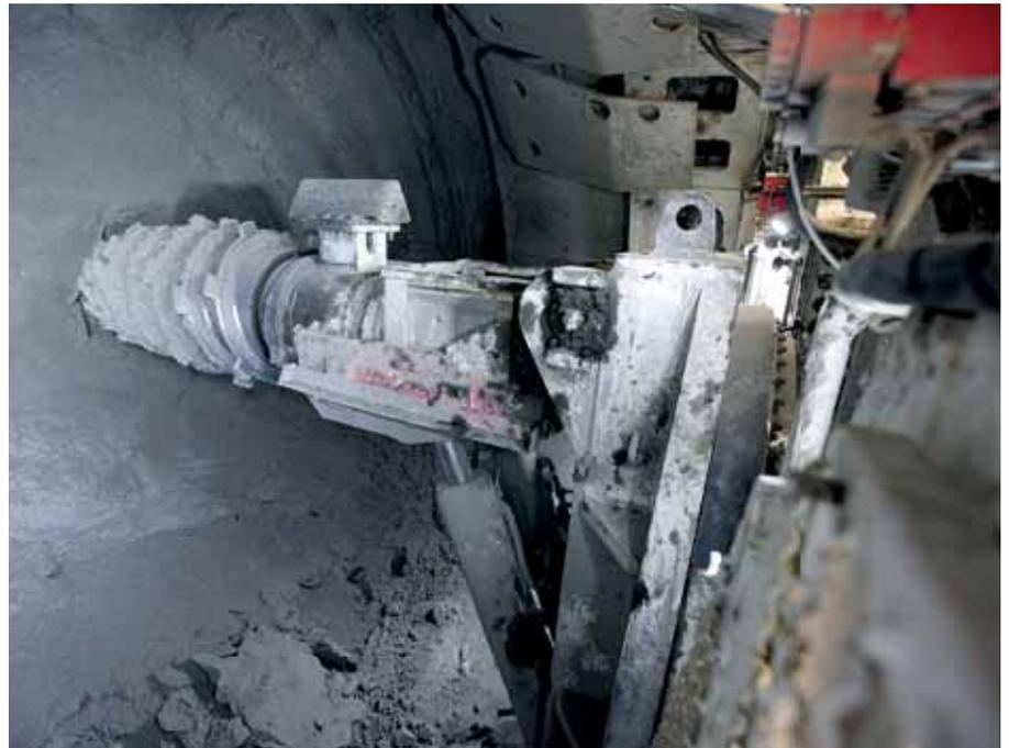
[voir la photo], sortes de boyaux métalliques qui avancent au fur et à mesure du creusement et dans lesquels l'opérateur est protégé, remplaceront les engins à attaque ponctuelle, comparables à des marteaux-piqueurs géants. « Dans le choix des optimisations retenues, la sûreté a primé. Nous avons cherché à rationaliser
