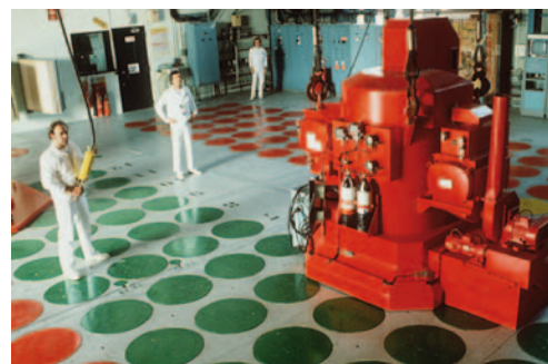
Puits d'entreposage de l'AVM
