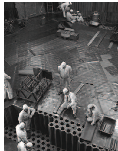
Empilements en construction
