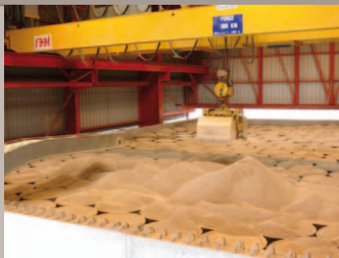
Remplissage d'une alvéole par du gravillon
