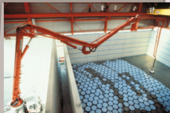
Cimentation d'une couche de colis
