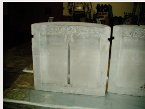
Coupe d'une coque béton pour expertise
