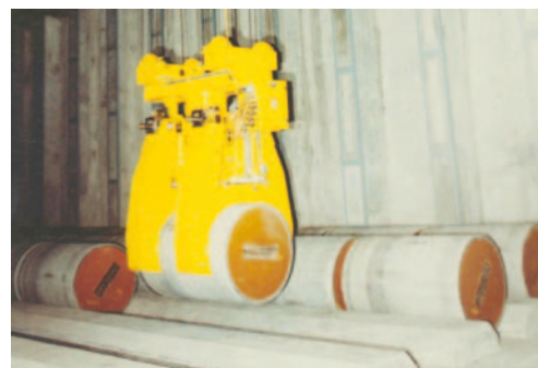
Alvéole d'entreposage des CAC
