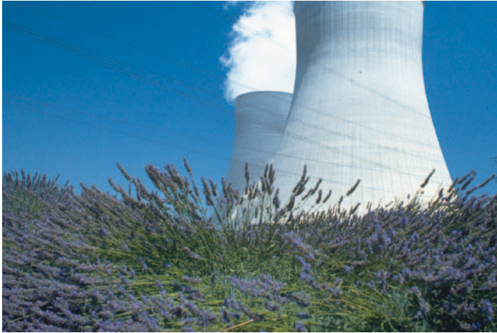
Centrale de Cruas
