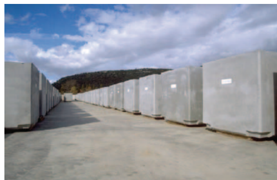
Conteneurs béton-fibres cubiques à Marcoule
