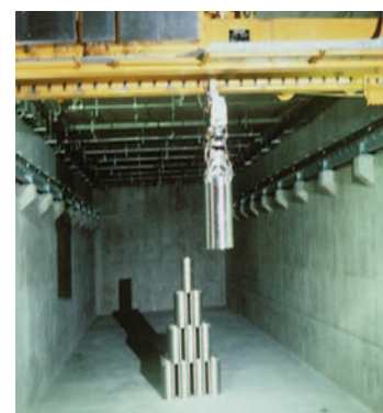
Entreposage des colis d'enrobés bitumineux
