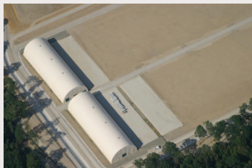
Alvéole de stockage
