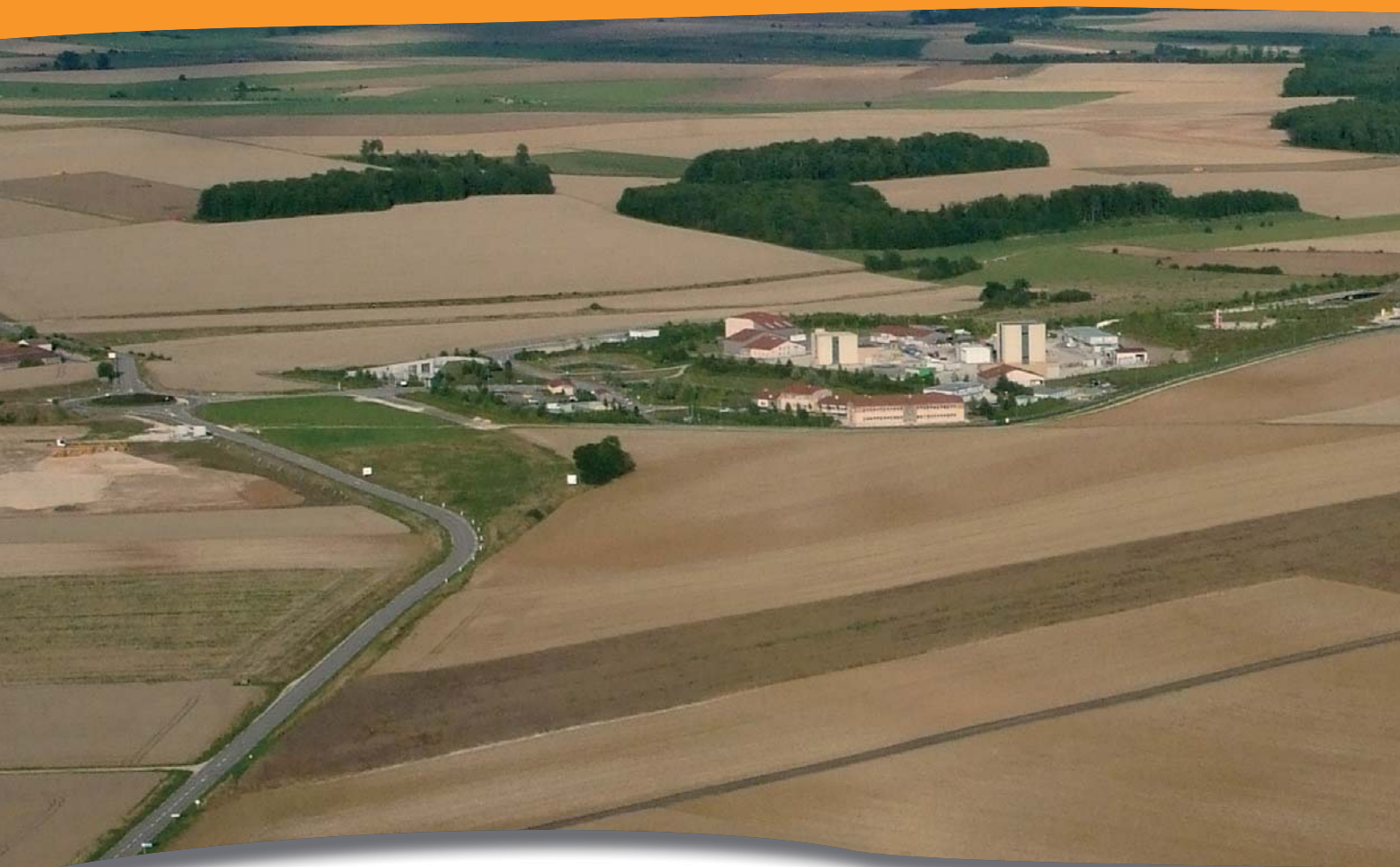
Vue aérienne de l'Espace technologique (à droite) et des installations du Laboratoire souterrain (au fond)
