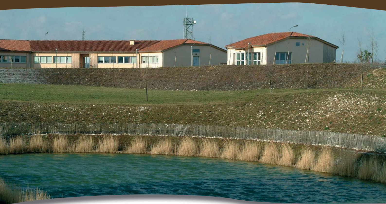
L'un des bassins d'orage du Laboratoire souterrain
