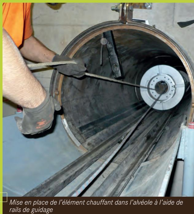
Mise en place de l'élément chauffant dans l'alvéole à l'aide de rails de guidage
