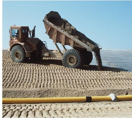
Illustration 81 : mise en place en 1995 des matériaux de la couverture au-dessus de la membrane bitumineuse avec un drain en premier plan
