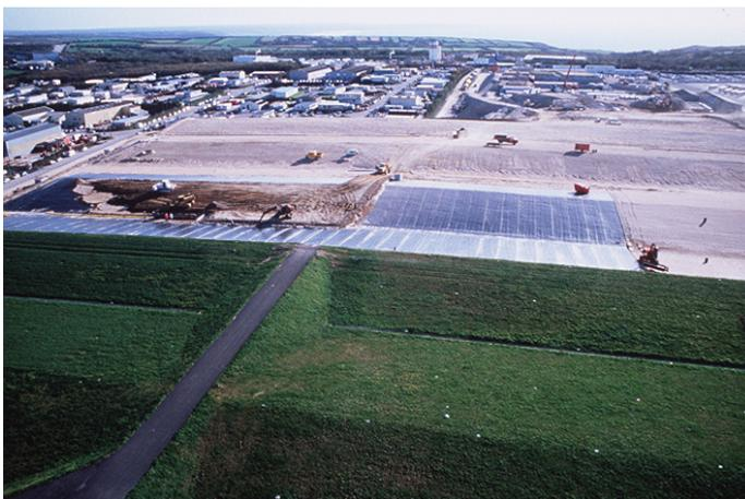
Illustration 112 : mise en place progressive de la couverture après la fin d'exploitation en 1995
