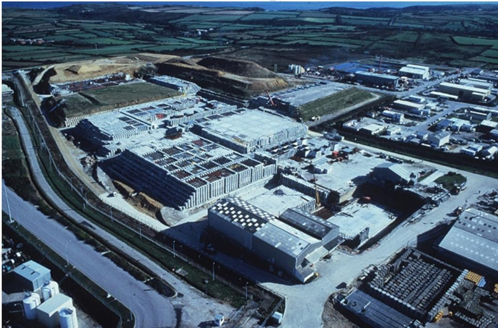
*Illustration 78 : couverture provisoire des ouvrages de la tranche 1 (au fond) pendant l'exploitation de la tranche 2 (au centre) et de la tranche 3 (devant) en 1991*
