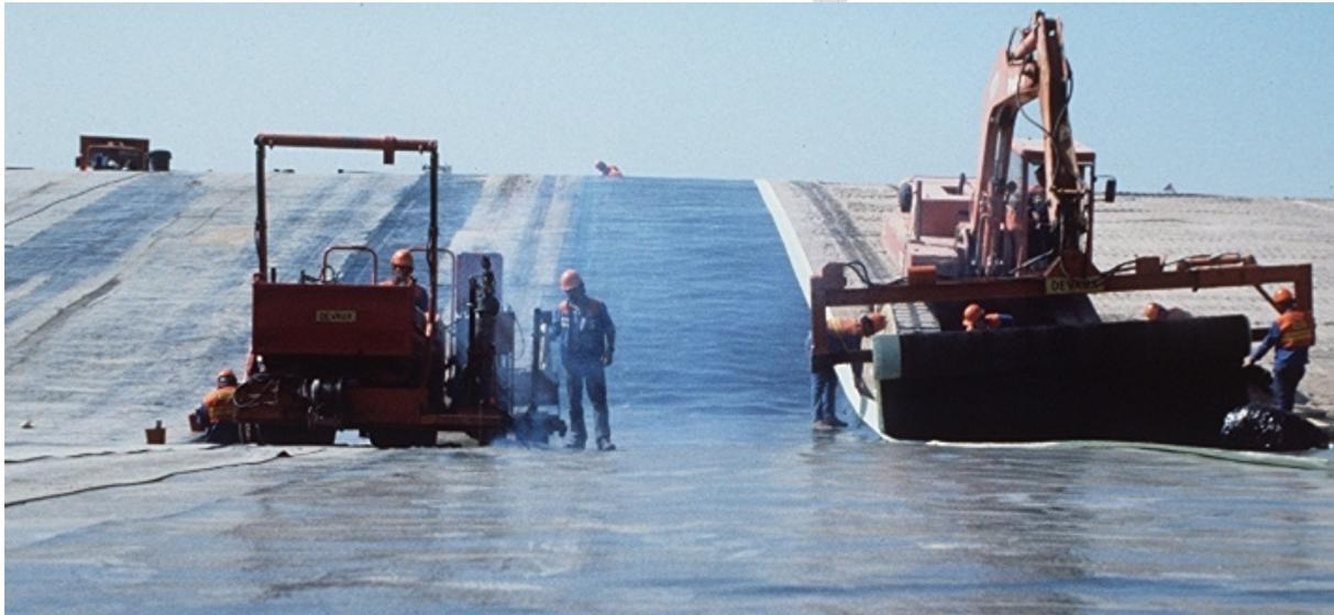
Illustration 108 : pose d'une bande de membrane bitumineuse en parallèle à son soudage en 1993
