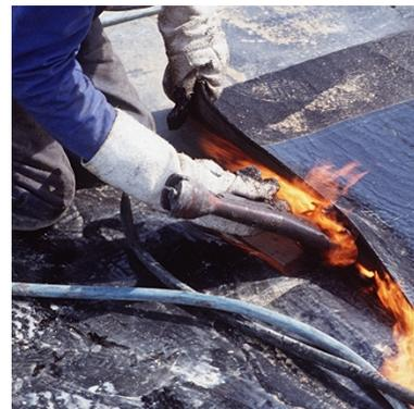
*Illustration 100 : soudure manuelle de la membrane bitumineuse à son raccordement avec les chambres de drainage en 1993*
