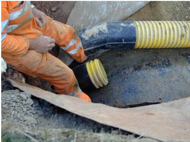
Illustration 89 : réparation en 2005 du déboîtement d'un drain sur membrane en tête de talus
