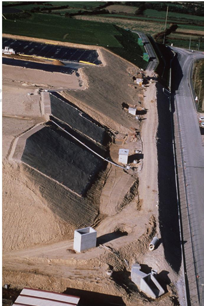
Illustration 115 : mise en place des matériaux sur les talus (à gauche), installation des chambres de drainage (à droite) et pose de la membrane bitumineuse (au fond) en 1995
