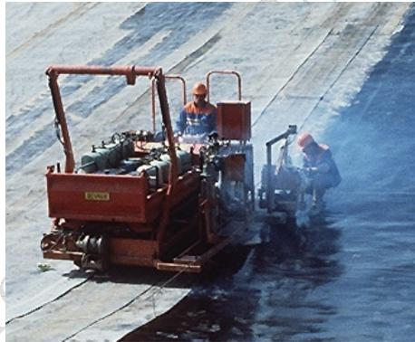
Illustration 82 : soudure automatique de deux panneaux de la membrane bitumineuse en 1995
