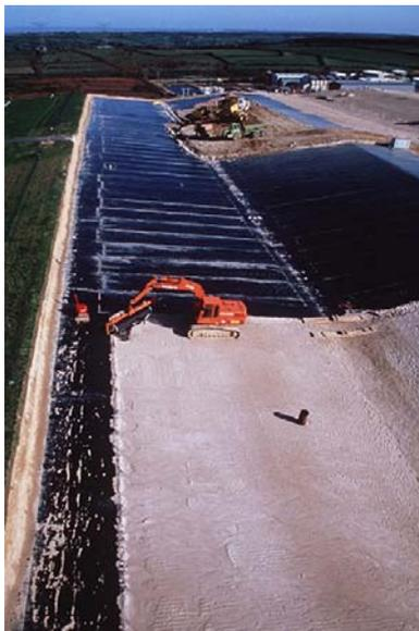
Illustration 103 : pose de la membrane bitumineuse (devant) et des matériaux au-dessus de cette membrane (au fond) pour la couverture en 1995
