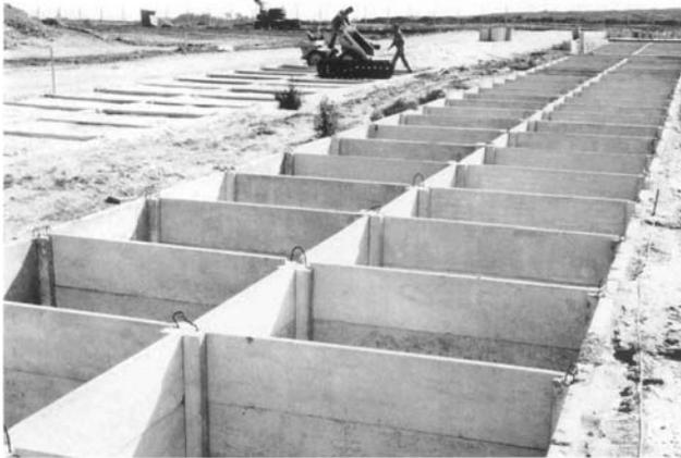
*Illustration 71 : tranchées bétonnées de première génération en cours de construction (1969)*
