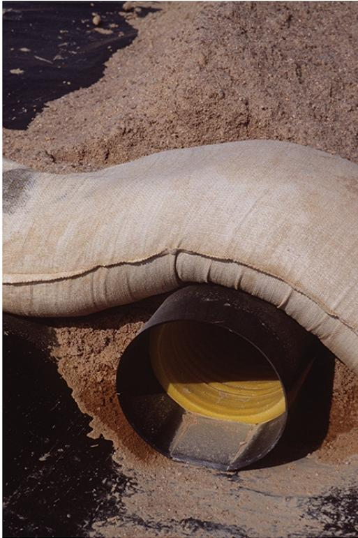
Illustration 97 : pose d'un drain au-dessus de la membrane bitumineuse en 1994
