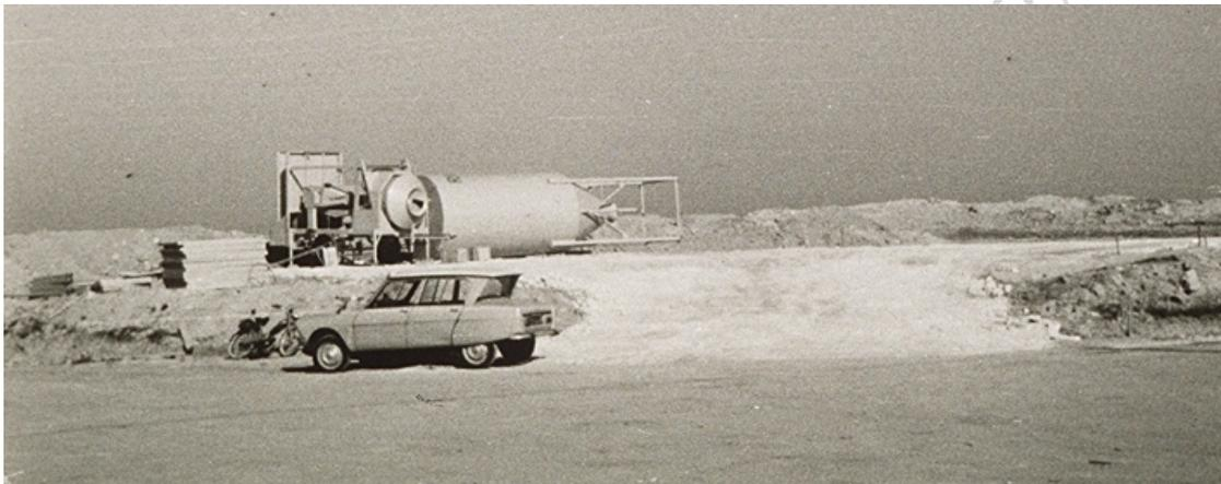
*Illustration 45 : installation de la centrale à béton sur le Centre de stockage de la Manche en 1969*
