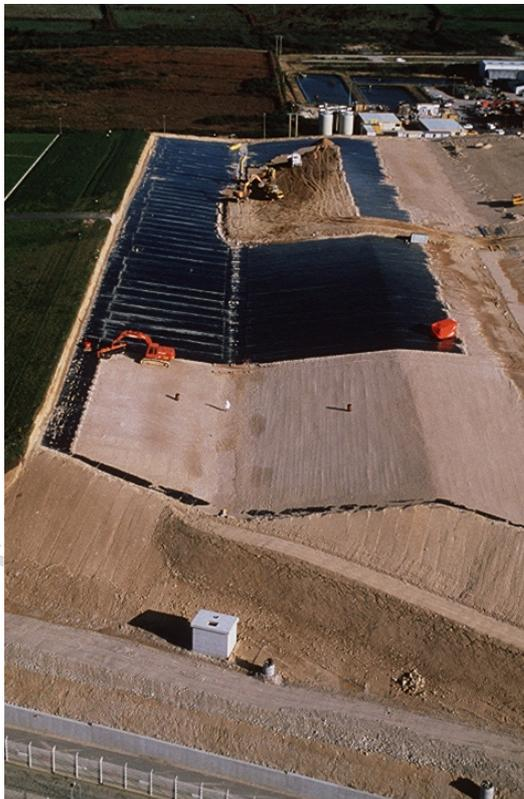
Illustration 85 : mise en place des matériaux au-dessus de la membrane bitumineuse et soutènement de la couverture (devant) en 1994
