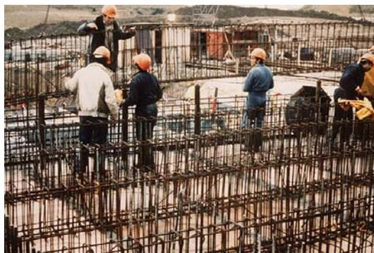
Illustration 105 : ferrailage d'une dalle de fermeture d'un ouvrage au-dessus des colis en 1978
