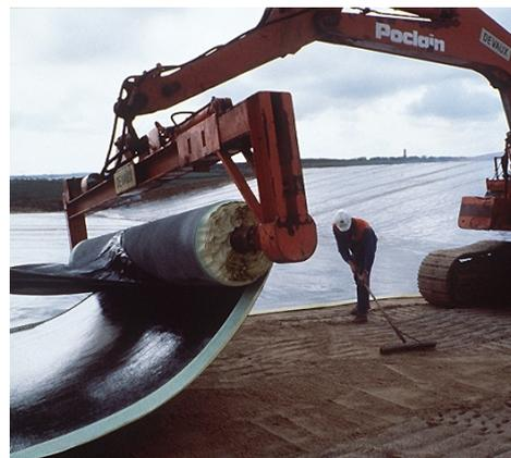
Illustration 80 : pose de la membrane bitumineuse en 1996
