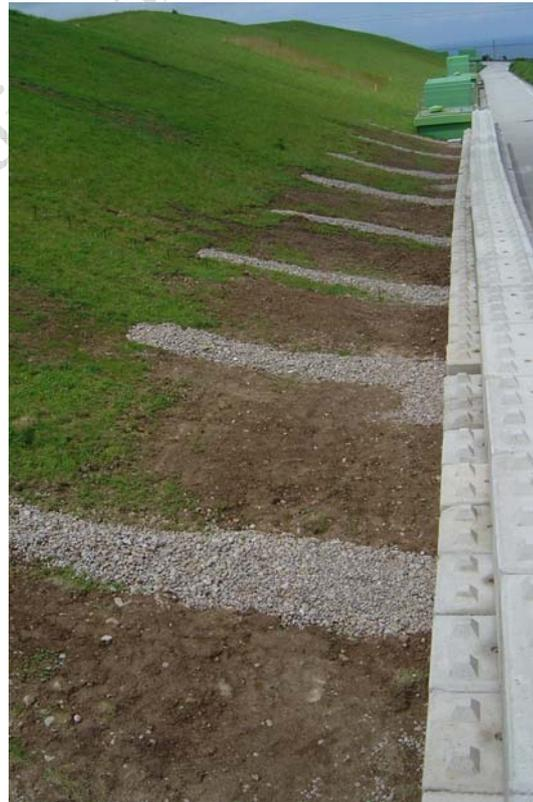
*Illustration 88 : mise en place d'un muret de soutènement de talus en 2007*
