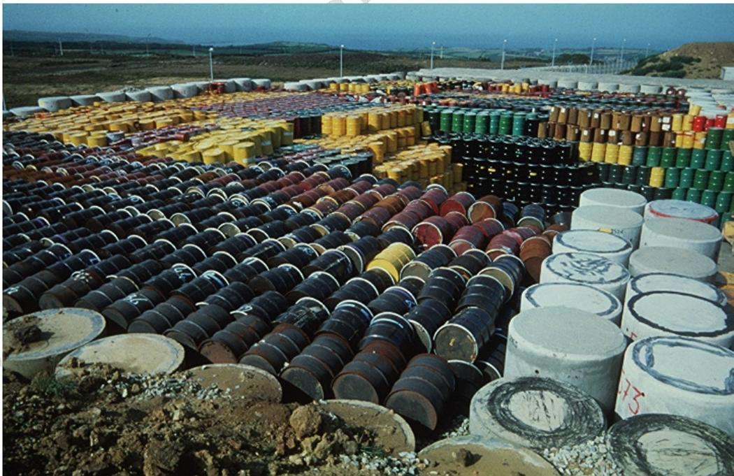
Illustration 63 : stockage des déchets radioactifs en fûts métalliques entre des coques béton en 1974
