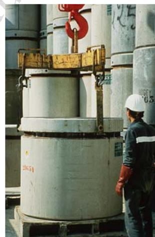
Illustration 46 : stockage d'un colis en coque béton en 1983
