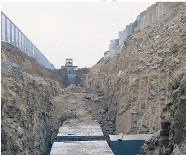
Illustration 90 : construction des réseaux de drainage profond en périphérie du stockage en 1984
