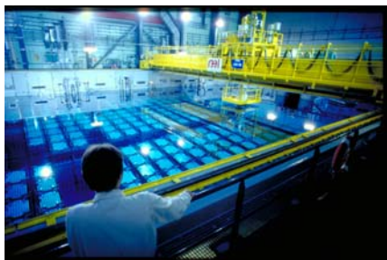
K - Piscine E, entreposage des combustibles usés. COGEMA La Hague COGEMA/P.Lesage
