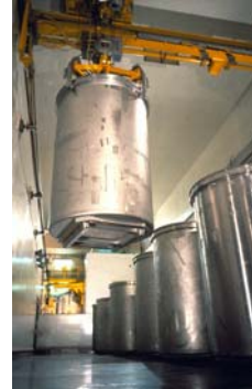
23 - Manutention de fûts contenant des coques et embouts cimentés dans le hall d'entreposage de l'usine UP3 de COGEMA La Hague
