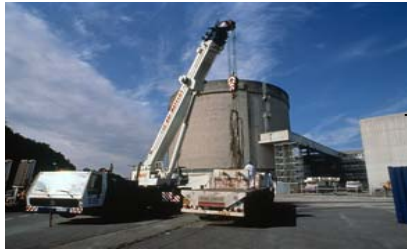
1 - Démantèlement de la centrale nucléaire de Brennilis
