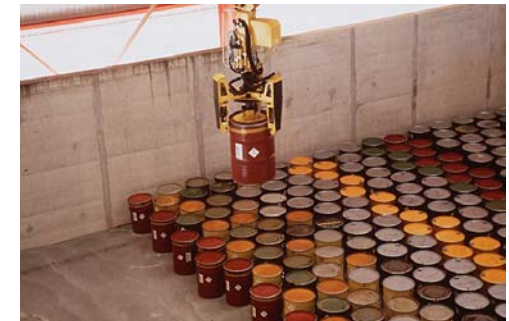
14B - Stockage de fûts métalliques Centre FMA de l'Aube
