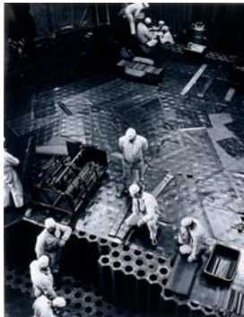
19 - Empilement de briques de graphite (à la construction), EDF Chinon
