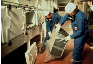
8 - Changement de filtre usagé d'un circuit de ventilation
