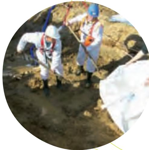
*A la rupture de pente la plus prononcée, il est apparu sous la seconde géomembrane des petites cavités.*
