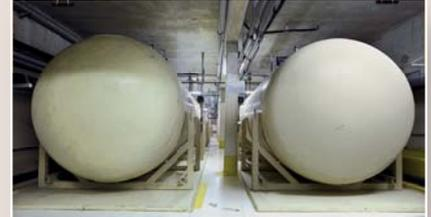
5. Cuves (contenant 10 m<sup>3</sup> chacune) dans lesquelles sont entreposés les effluents à risque.
