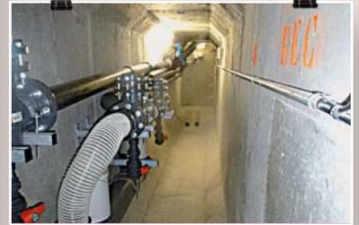
4. Galerie souterraine. Située sous les ouvrages de stockage, elle récupère les eaux d'infiltration qui traversent les ouvrages.
