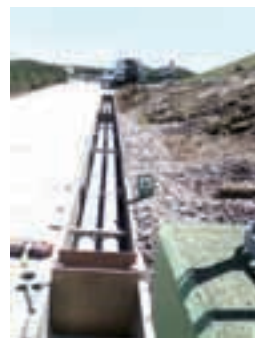
Préparation des caniveaux pluviaux
