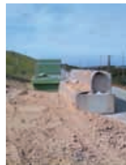
Pose du mur poids
