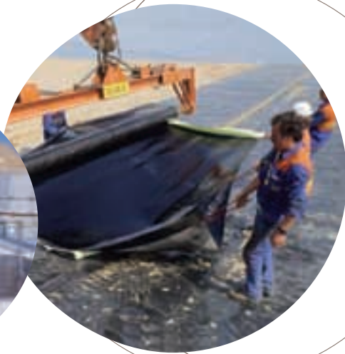
Pose de la membrane bitumineuse
