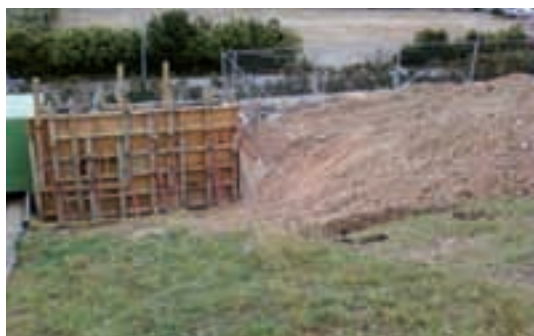
Coffrage des murs de soutènement
