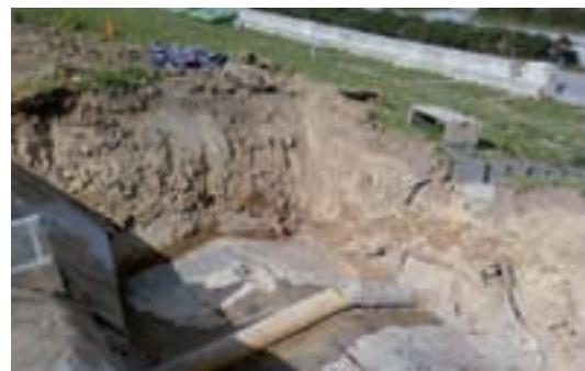
Inspection de la crête de talus
