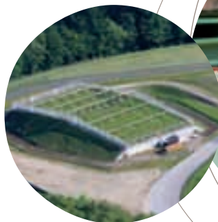
Structure expérimentale de couverture
