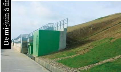
est du Centre. Le mur de soutènement en béton de 1,60 m de haut, qui fait office de « cale », a été déplacé, pendant que la partie basse du talus, en appui sur le mur, a été comblée avec des matériaux en provenance des carrières de Cherbourg. Achevée à la fin de l'été, cette première tranche de travaux sera dupliquée sur d'autres parties du site.
