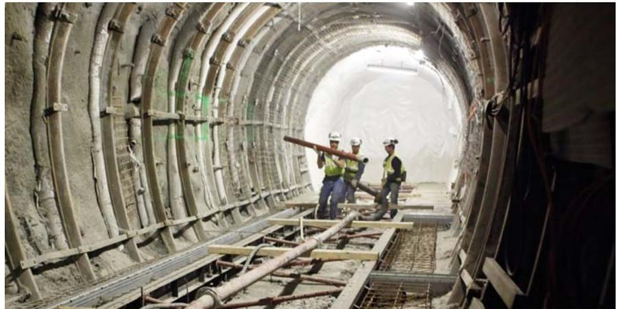
nements. En novembre 2010, un tronçon d'une quarantaine de mètres de galerie a été enduit de béton et truffé de capteurs, qui enregistreront les réactions du terrain pendant plusieurs années. Ces données seront comparées avec les résultats des essais de soutènement menés dès 2005 à l'aide de poutrelles métalliques capables de coulisser. Une autre alternative
