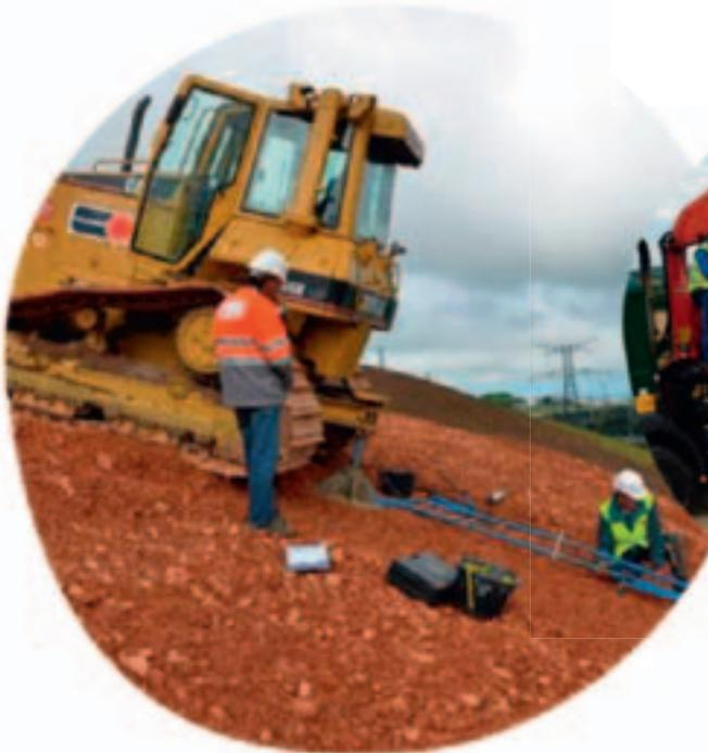
*Contrôle du remblai : Essai à la plaque*
