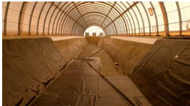
Au CSTFA, les déchets sont stockés en surface dans des alvéoles, de 176 mètres de long et 25 mètres de large environ, creusées à quelques mètres de profondeur dans une couche argileuse. Une fois remplies de déchets, ces alvéoles sont fermées par une couverture dite provisoire composée :
