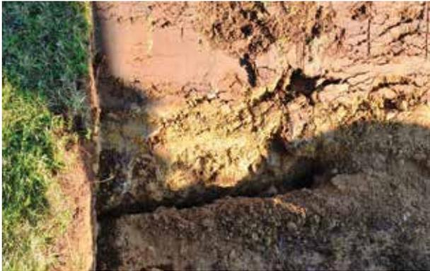
Présence d'une fissure ouverte dans les schistes du panneau 106 Est
