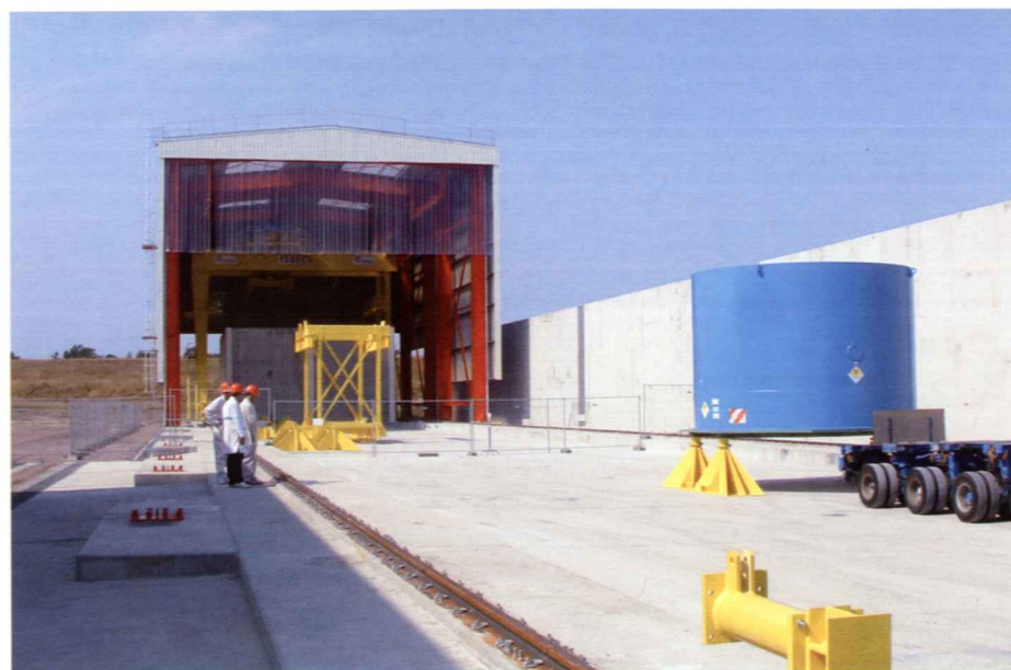
Dépose du couvercle de cuve avant stockage
