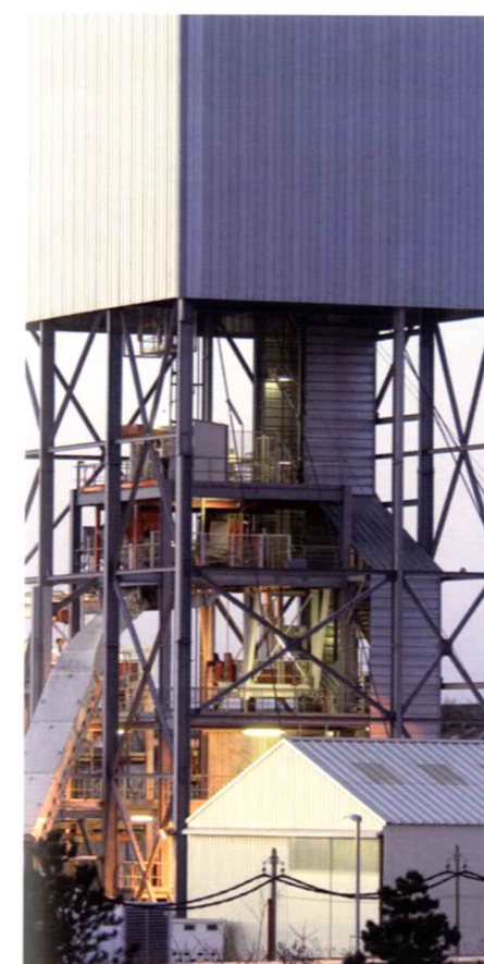
Puits du Laboratoire de Meuse/Haute-Marne
