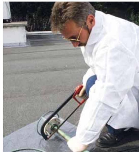
Prise en charge d'un paratonnerre au radium.
