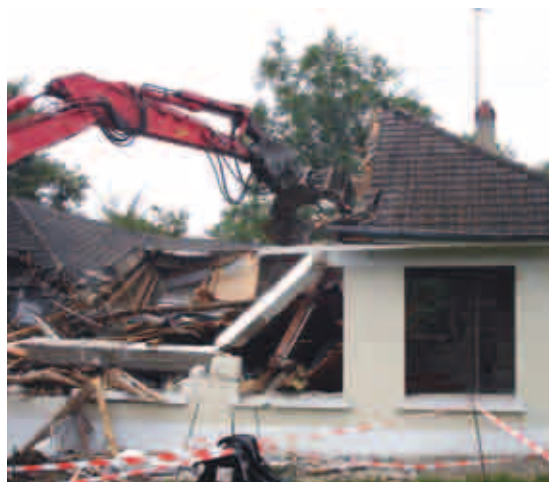
Démolition d'une maison en octobre 2013 dans le quartier des Coudraies.
