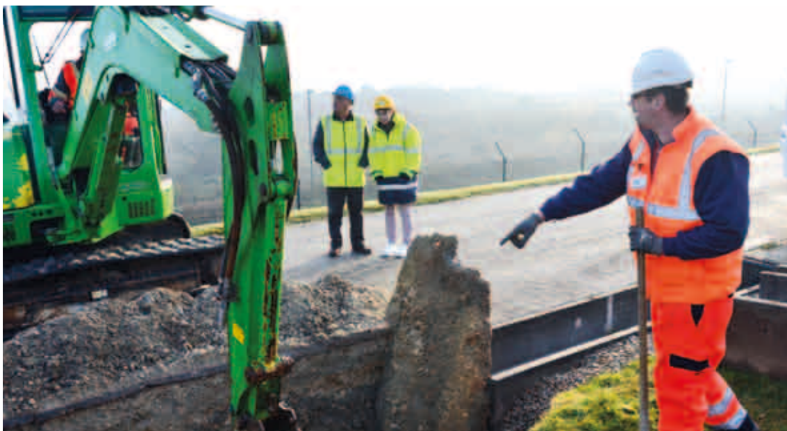
Travaux sur la couverture du CSM.
