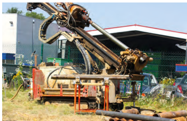
Des forages ont été réalisés pour déterminer les caractéristiques géotechniques des terrains.
