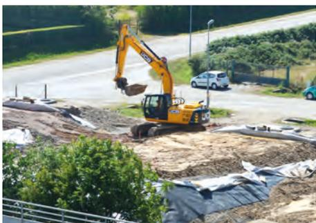
Réalisation des planches d'essai.
