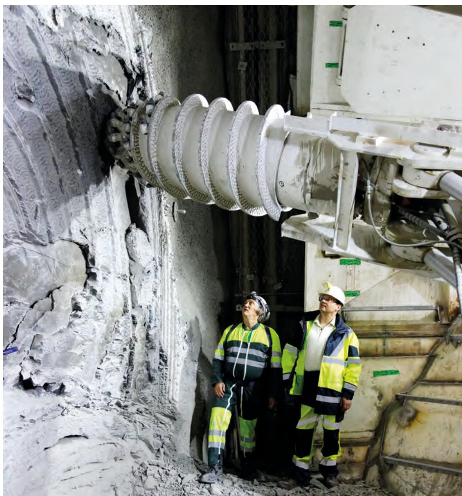
Tête de forage du tunnelier dans le Laboratoire souterrain.
