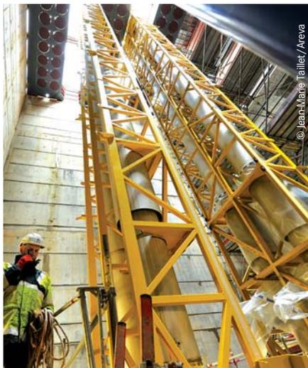
Mise en place d'un puits d'entreposage de conteneurs sur le site Areva de la Hague. Un hall est aujourd'hui en activité et un second est actuellement équipé au sein du bâtiment EEV.
