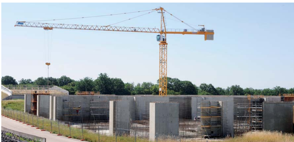
Travaux de construction de nouveaux ouvrages de stockage dans l'Aube.
