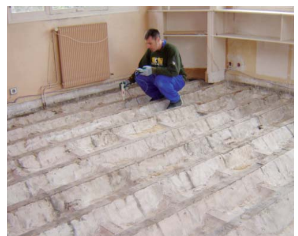
Contrôle de la contamination résiduelle après retrait du plancher contaminé.
