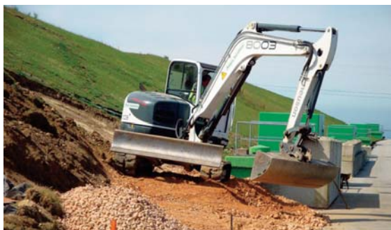
Mise en place des matériaux de comblement dans la Manche.
