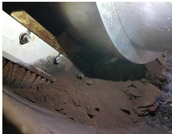
*Nettoyage des débris de produits de corrosion au sein d'un tronçon de chemisage*
