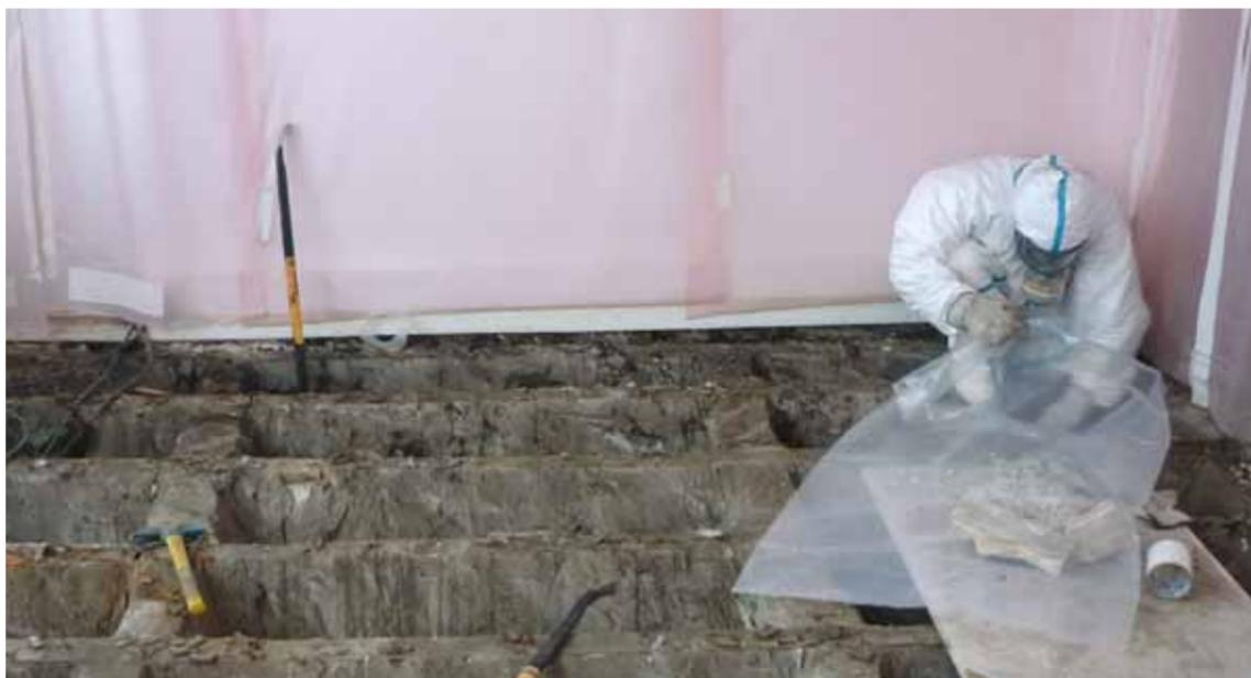
La décontamination a nécessité le traitement de toutes les surfaces, mais également des lambourdes et des poutres porteuses.
