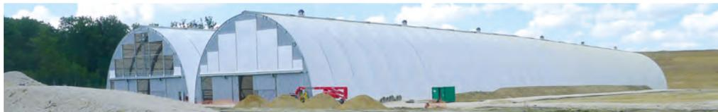
Destiné à protéger les futures alvéoles du Centre industriel de regroupement, d'entreposage et de stockage (Cires), ce toit-abri, baptisé Prémorail, est composé d'une structure métallique bâchée montée sur rails. L'innovation porte sur trois aspects : l'autonomie : le déplacement des structures modulables et fractionnables s'effectue par tronçons grâce aux rails
