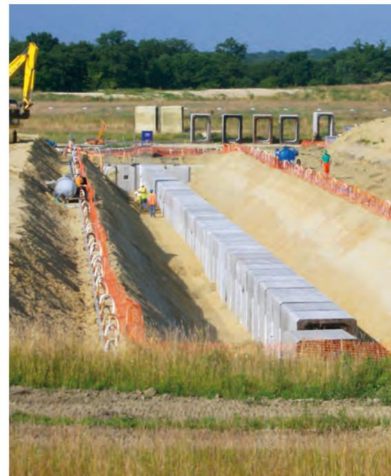
Ce nouveau chantier de construction d'ouvrages de stockage démarre, comme pour le précédent, par l'installation des galeries souterraines de surveillance. (photo d'archives Tranche 8)
