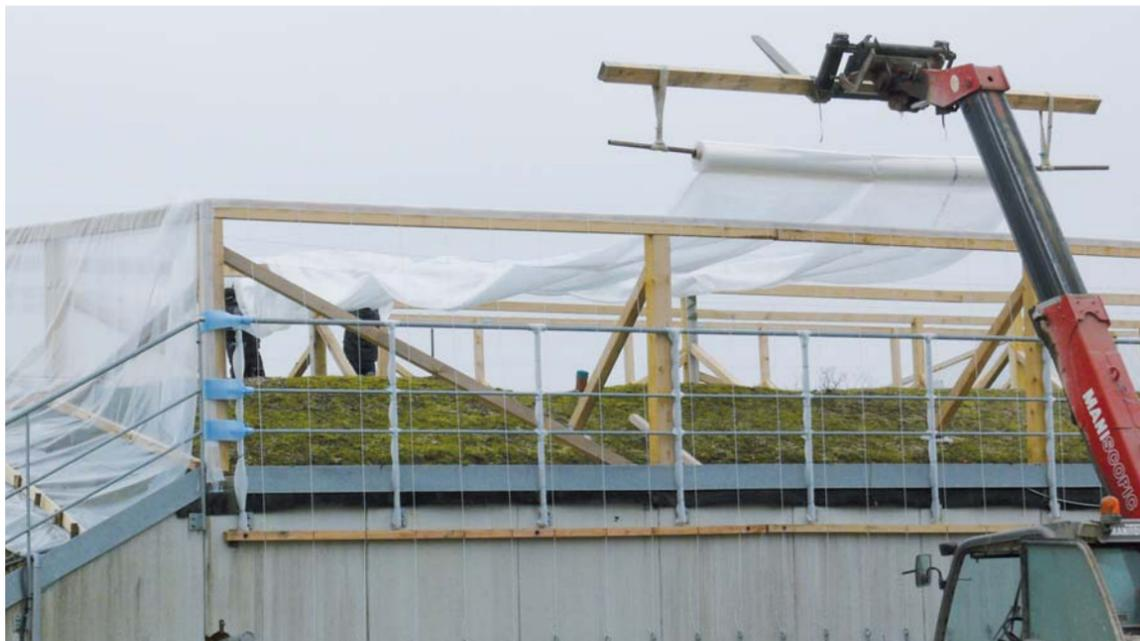
Mise en place de la serre sur la Structure expérimentale de couverture.
