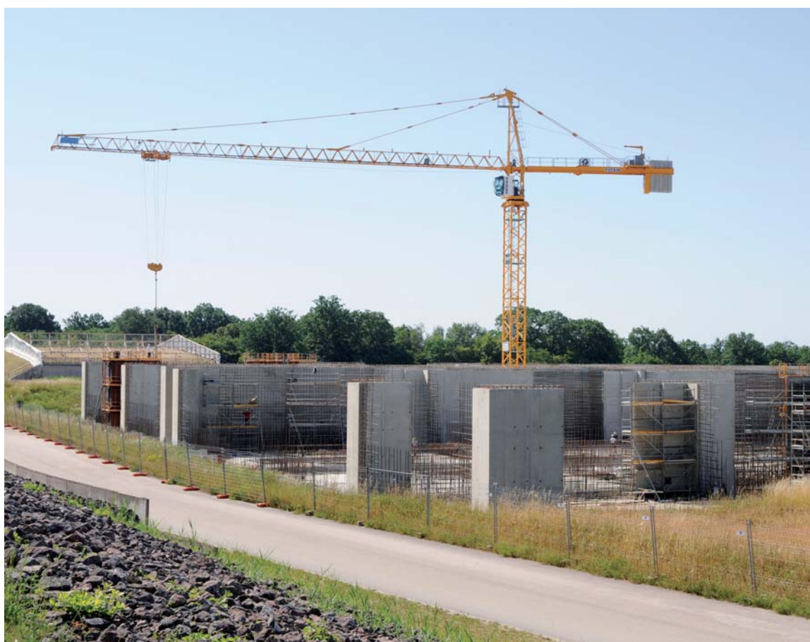
Travaux de construction de nouveaux ouvrages de stockage au CSFMA.
