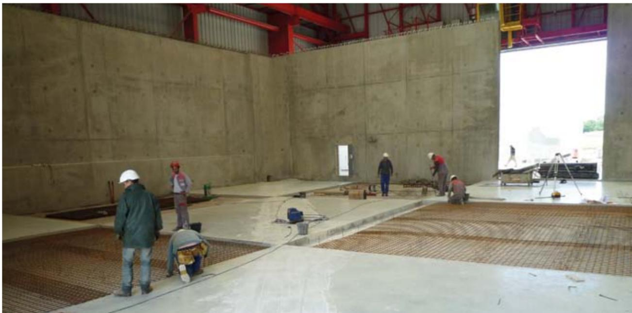
Pose du béton de la couche de forme dans un ouvrage de la tranche 8.
