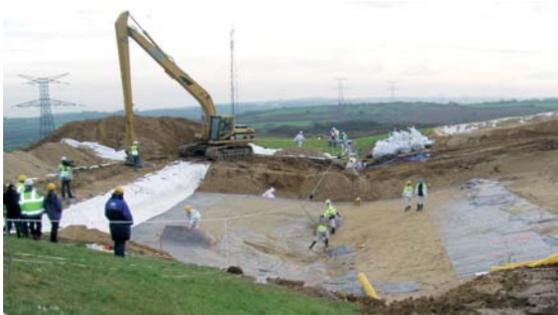
La mise à jour de la membrane bitumineuse a permis de constater sa résistance au tassement.
