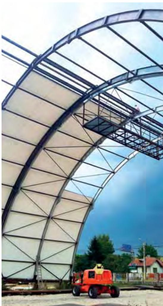
Assemblage du toit abri mobile conçu pour le Cires.
