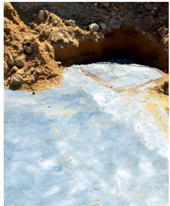
Membrane dégagée pour contrôle et relevé topographique.
