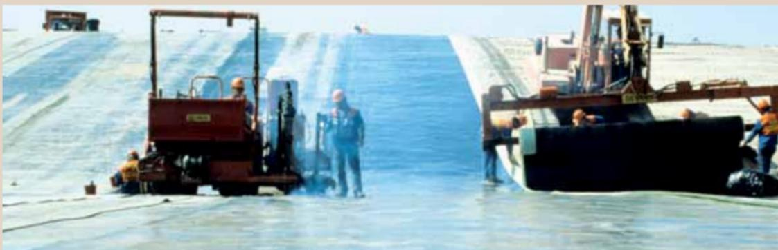
Pose et soudure de la membrane bitumineuse.
