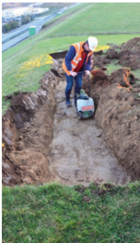
Remise en place et compactage de la terre végétale.
