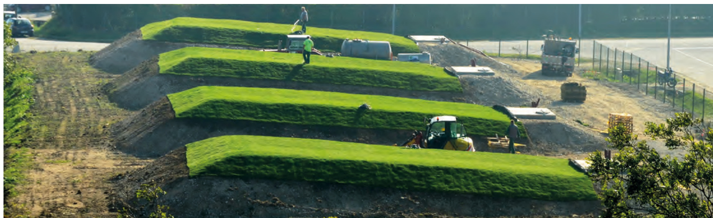
Vue sur les quatre planches d'essai.
