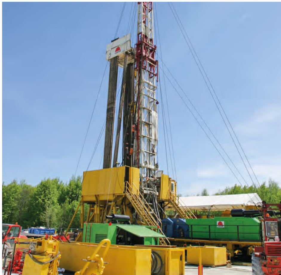
Le forage de l'été 2008 réalisé au milieu de la forêt de Montiers-sur-Saulx a atteint 2000 m de profondeur. Les mesures ont montré que le potentiel géothermique des nappes d'eau du Trias ne présentait pas un caractère exceptionnel.
