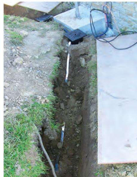
Réalisation d'une tranchée pour l'installation des câbles électriques.
