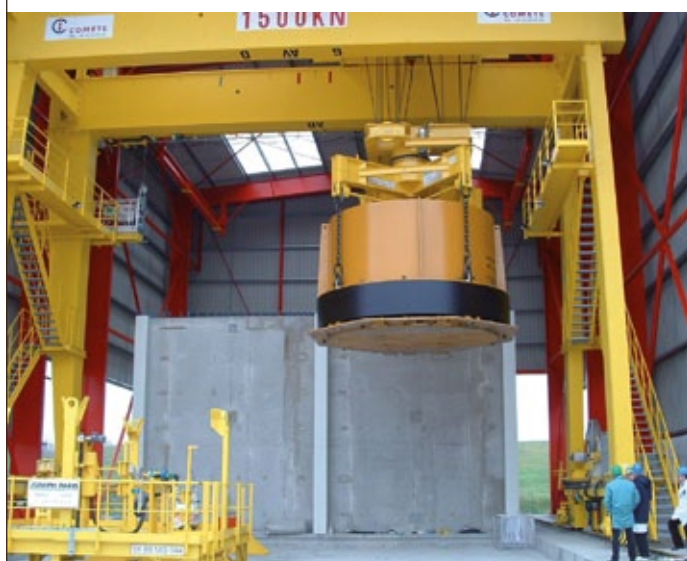
Exemple de prise en charge d'un colis de grandes dimensions : stockage d'un couvercle de cuve de réacteur au Centre de l'Aube.
