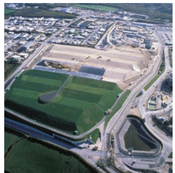
Mise en place de la couverture du Centre de stockage de la Manche (1993).
