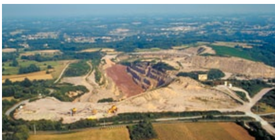
L'ancienne mine d'uranium de Bellezane (87) en exploitation et après réhabilitation.
