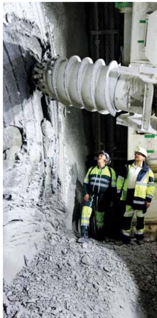
À l'avant du tunnelier, les dents montées sur un bras articulé mordent l'argile.
