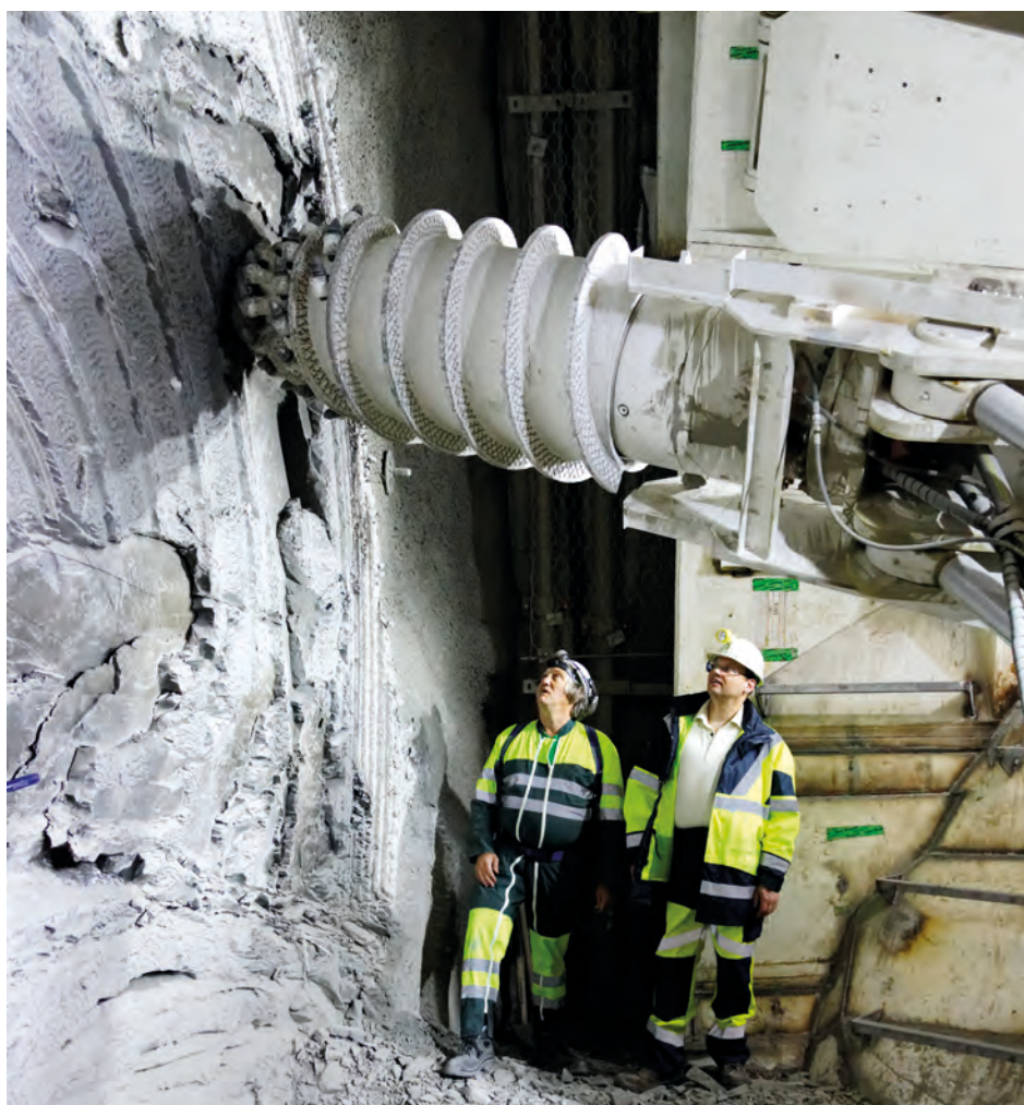
Tête de forage du tunnelier dans le Laboratoire souterrain.
