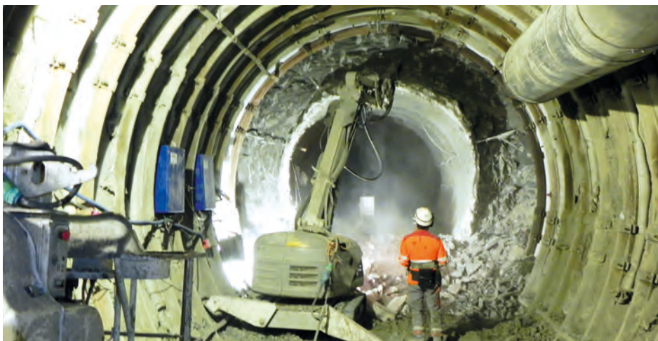
La galerie en petit diamètre a été élargie trois mois après le creusement initial.
