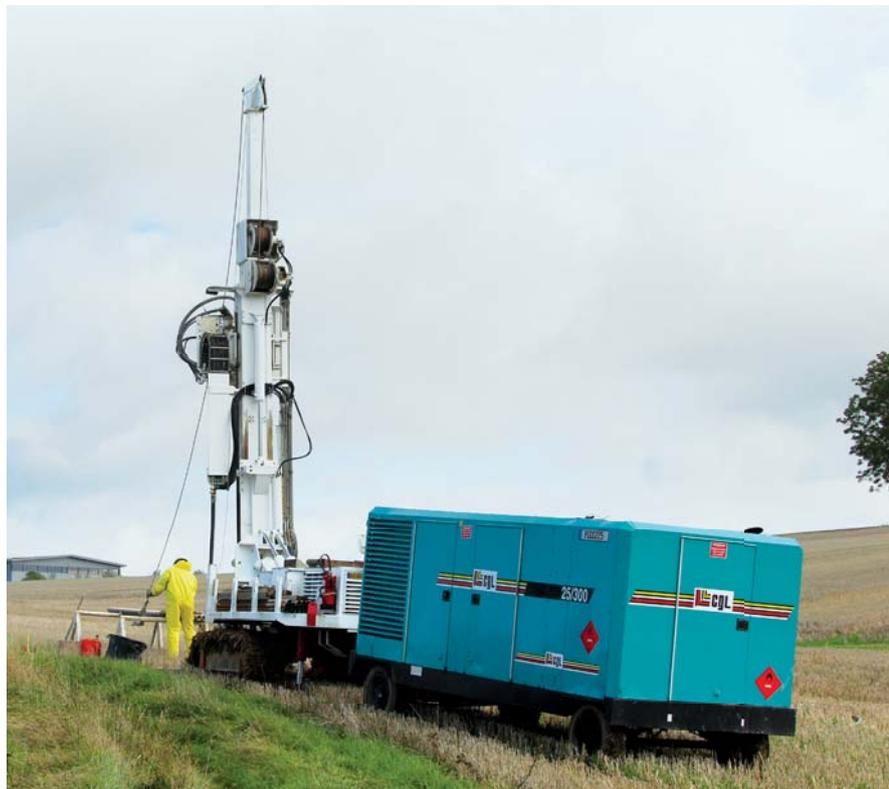
Les sondeuses réalisent les forages pour la reconnaissance géotechnique. Les données acquises permettent d'étudier les dimensions des bâtiments de la zone de transit des déchets radioactifs entre la surface et le fond.
